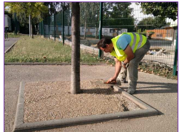
Mise en œuvre de résine drainante en pied d'arbre
