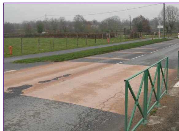
Résine arrachée par une circulation trop dense
