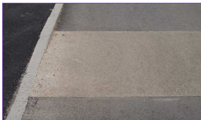
Résine avec granulats sur enrobé de couleur
