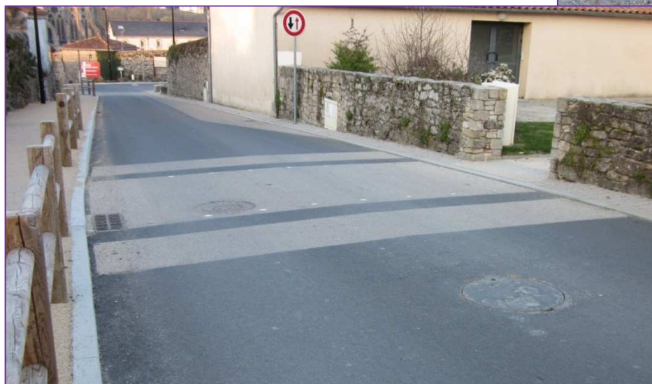
Marquage en résine avec granulats – SAINT LAURENT SUR SEVRE
