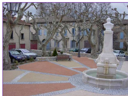
Résine drainante sur une place
