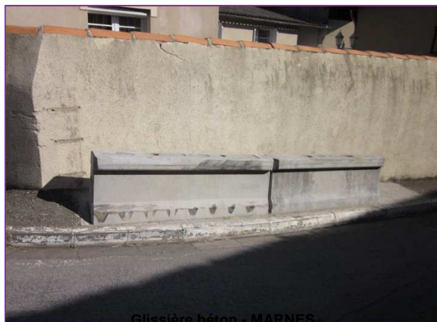
Glissière béton - MARNES
