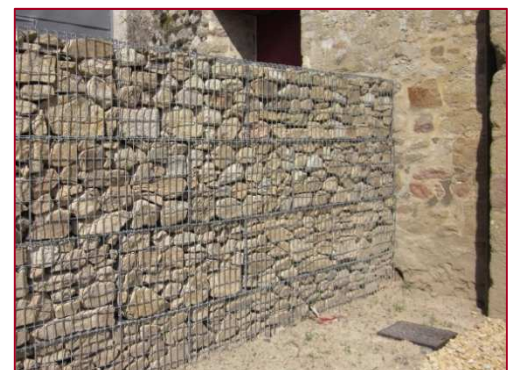
Claustra en gabions
