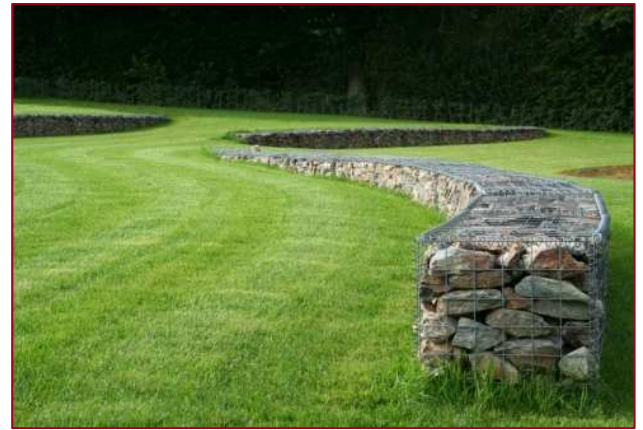
Claustra en gabions
