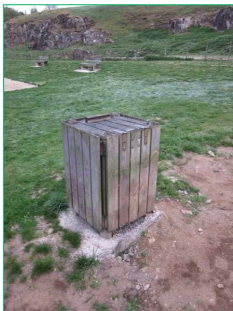
Poubelle en bois – Développement de végétaux, grisonnement du bois, dégradations volontaires
