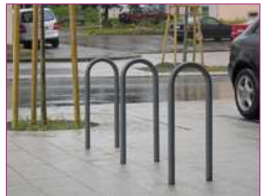
Supports vélos sous forme d'arceaux en acier
