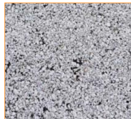
Aperçu détaillé de béton poreux
