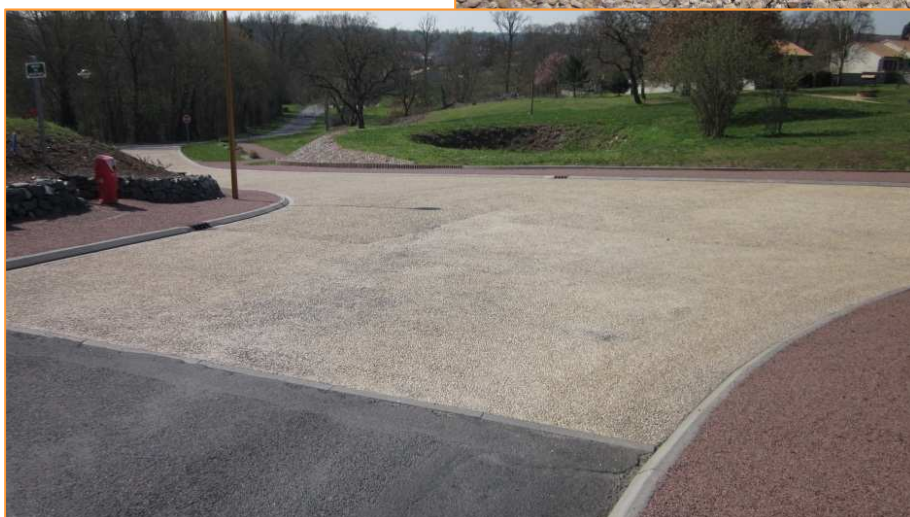
Béton désactivé – SAINT VARENT Carrefour sécurisé
