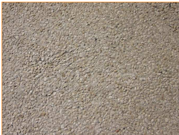
Aperçu détaillé – Béton désactivé – SAINT VARENT
