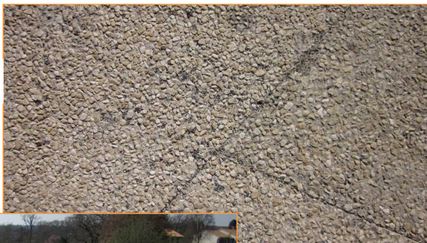
Aperçu détaillé des joints dans un béton désactivé
