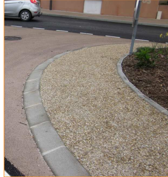
Béton désactivé sur trottoir - BRESSUIRE
