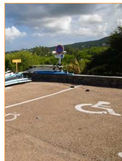
Zone de stationnement en béton poreux
